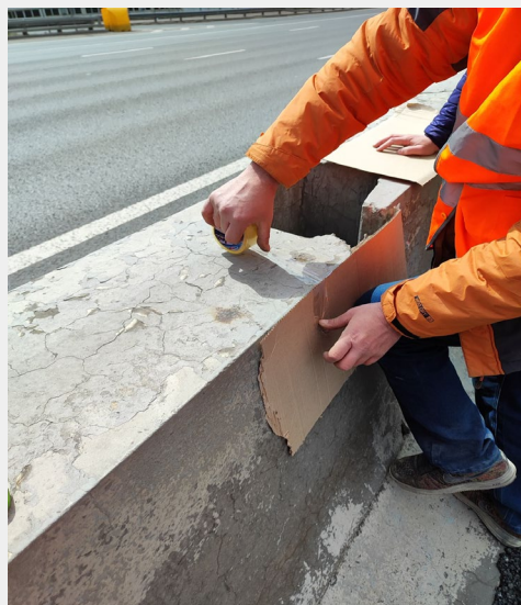
РЕМОНТ ОТБОЙНИКОВ НЬЮ-ДЖЕРСИ
