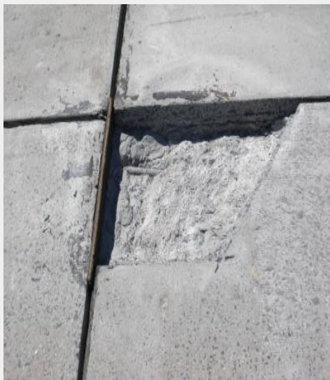
ЗАПОЛНЕНИЕ СКОЛОВ И ТРЕЩИН
